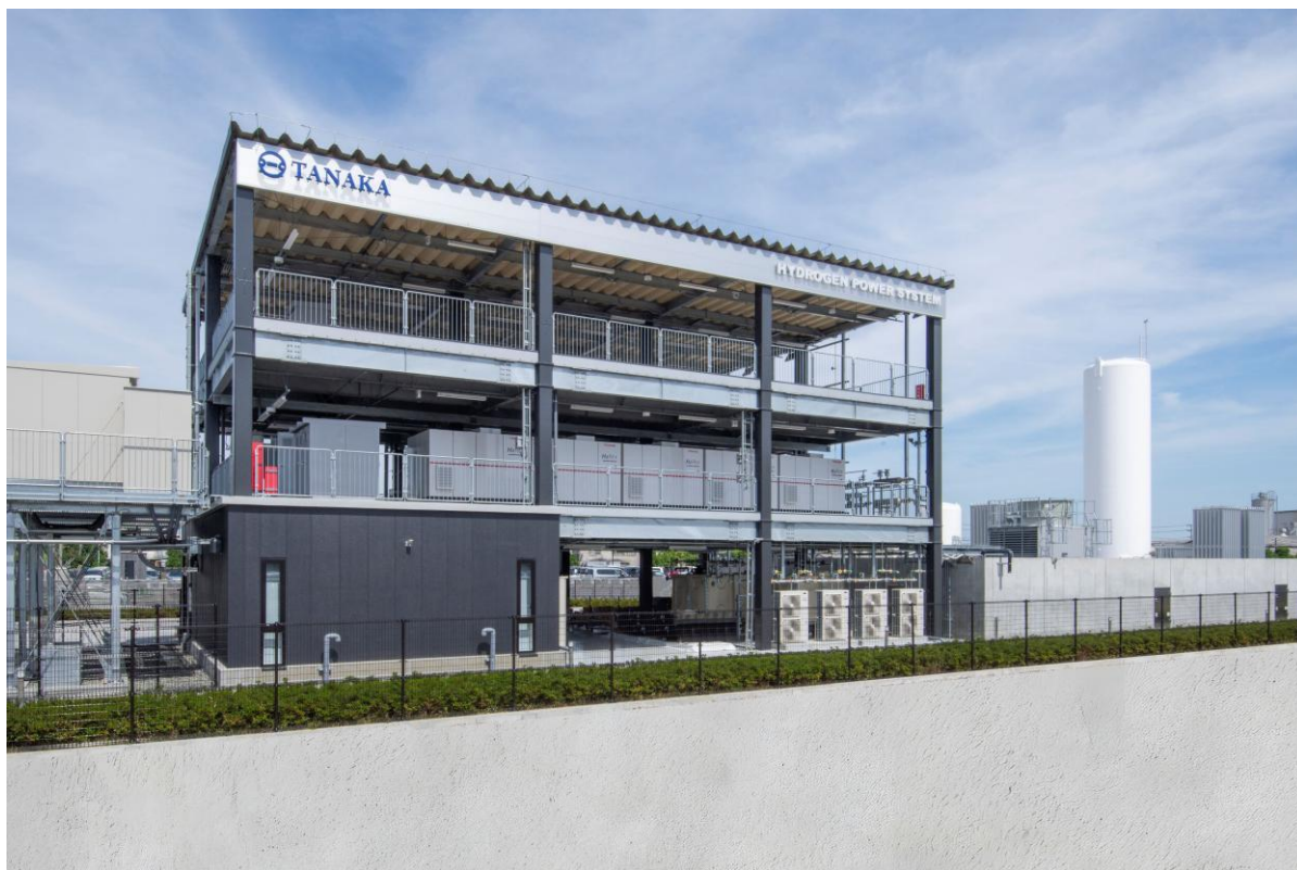
<田中貴金属工業湘南燃料電池発電所 燃料電池発電設備「TANAKA H2 Nexus」>
